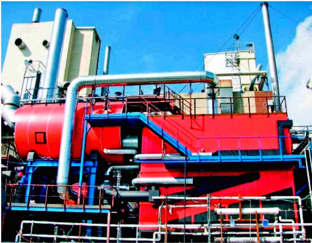
דוד קיטור במפעל הקפה של שטראוס בצפת שהוסב להפעלה באמצעות שאריות של פולי קפה (צילום: יח"צ)
